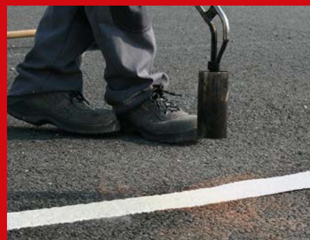
Termoplastické značení na asfalt a beton
