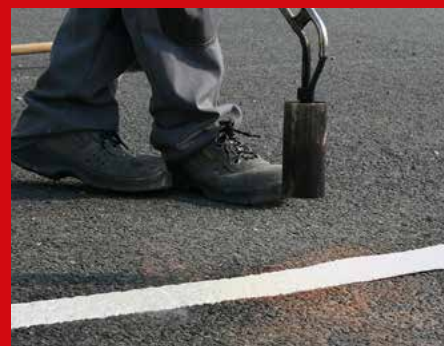
Termoplastické značení na asfalt a beton
